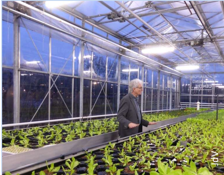
Figuur 3: Tilapia's (rechts), klein-kroosbedden (groen), basilicumbedden (links) en in het midden de waterzuivering (blauw) met een platenbezinkter (voorgond), tricklefilter met opvangbak en pompbak.
